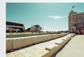
1. Secteur du Square de l'Armade : l'ouvrage de protection est composé de murets, de bancs dont l'assise se relève, et de batardeaux qui s'appuient sur des bâtiments existants
