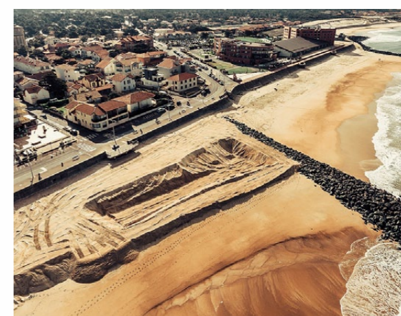
Travaux de réensablement (by-pass), plage centrale de Capbreton [40]
