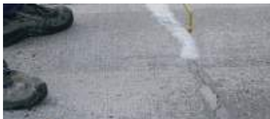
Béton autocicatrisant : application du système de réparation (liquide Basilisk ER7 ) © Basilisk Self-Healing Concrete
