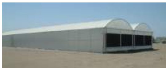
La Seawater Greenhouse à Oman juste après son achèvement © Charlie Paton
