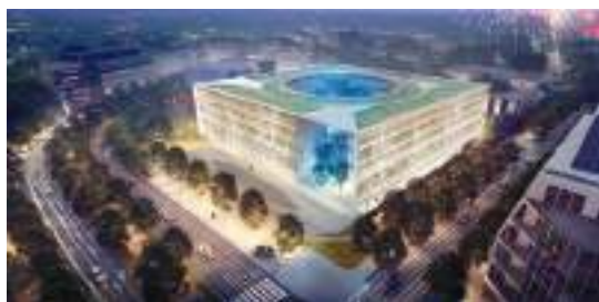
Vue aérienne numérique du CIRC-IARC à Lyon © ArtBuild
